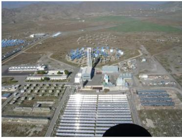
Es gibt weltweit einige verschiedene Pilotprojekte, von denen z.B. das Hydrosol-Projekt des DLR zu nennen ist, das nach früheren Erfolgen für eine 10 kW Anlage momentan auf 100 kW mit Partnern aus Spanien und Griechenland im Almeria in Spanien erweitert wird (Hydrosol 2, s. nebenstehendes Bild).<sup>6</sup> Unter anderem sind Ni/Zn/Fe-Oxid Systeme im Test, die bereits ab 800°C Wasserstoff produzieren.
